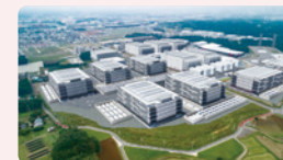
データセンター
