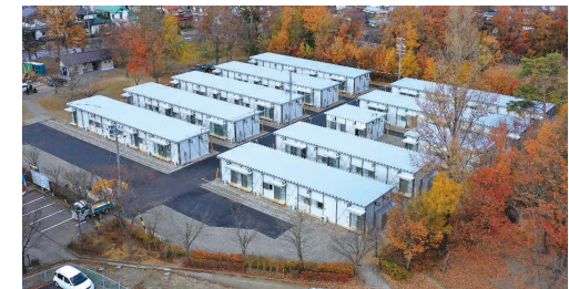
応急仮設住宅
