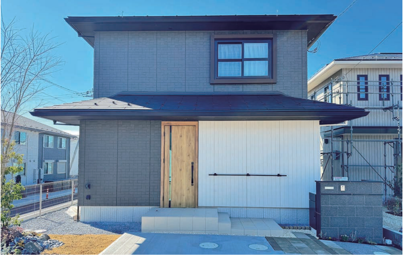
6号地外観写真(2024年2月撮影)
