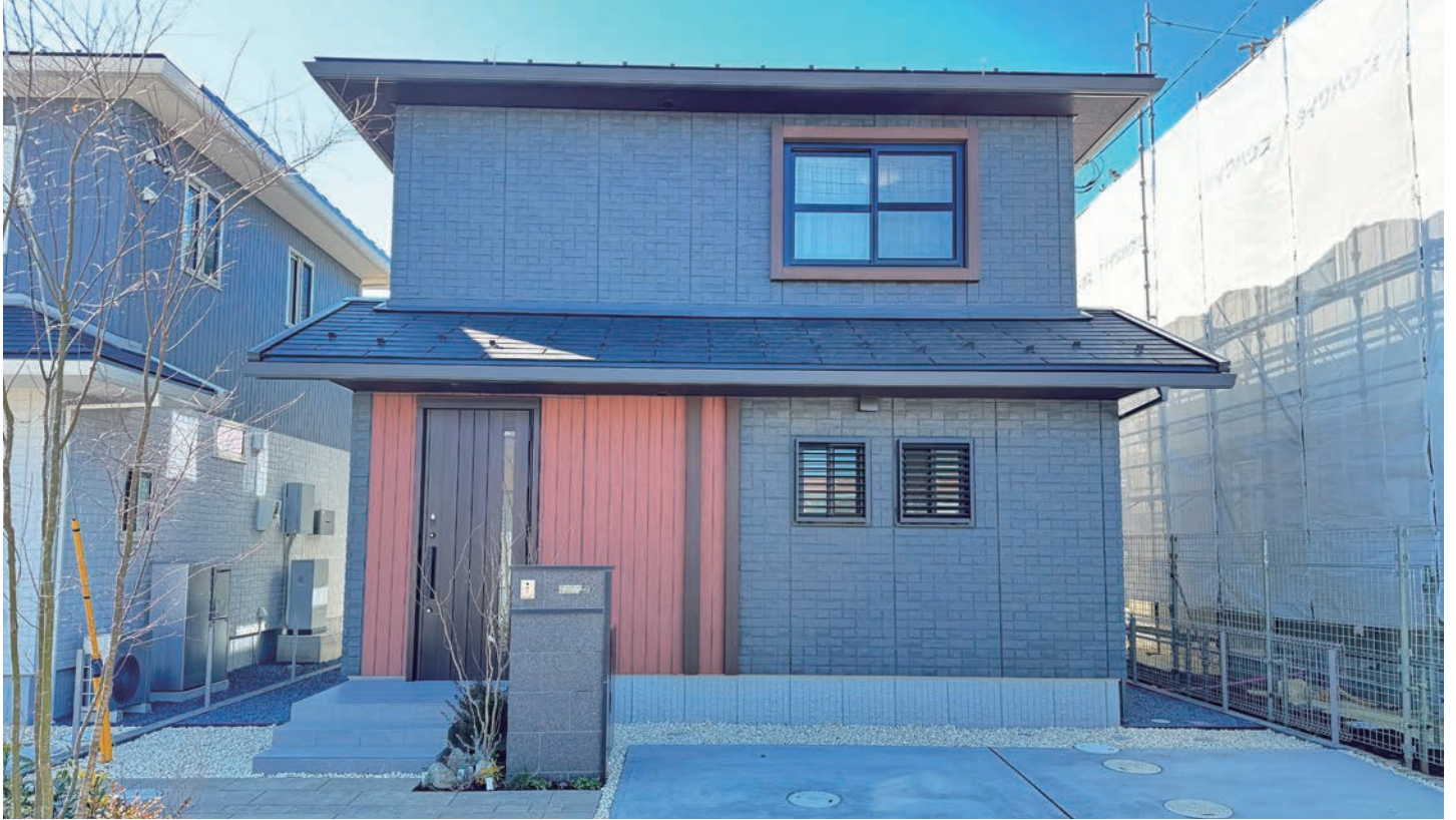
9号地外観写真(2024年2月撮影)
